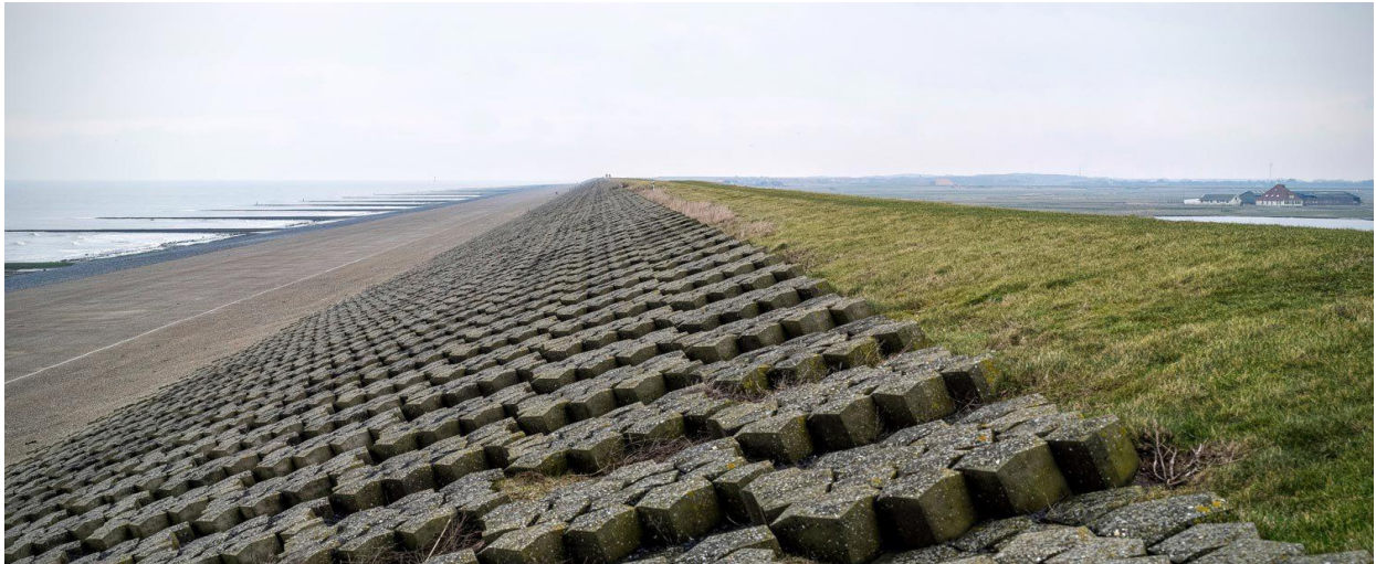
Voorbeeld ruwer talud: Kunstmatige ribbels in de Hondsbossche Zeewering en Pettemer Zeewering
