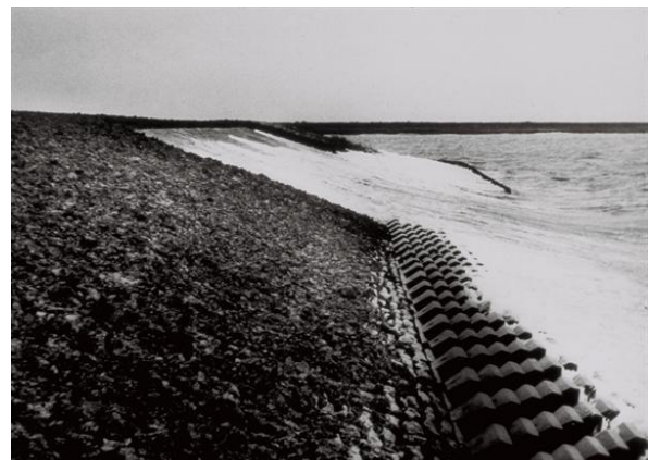
golfploop door het ruwe talud wordt geremd, in vergelijking met het dijkgedeelte daarachter
