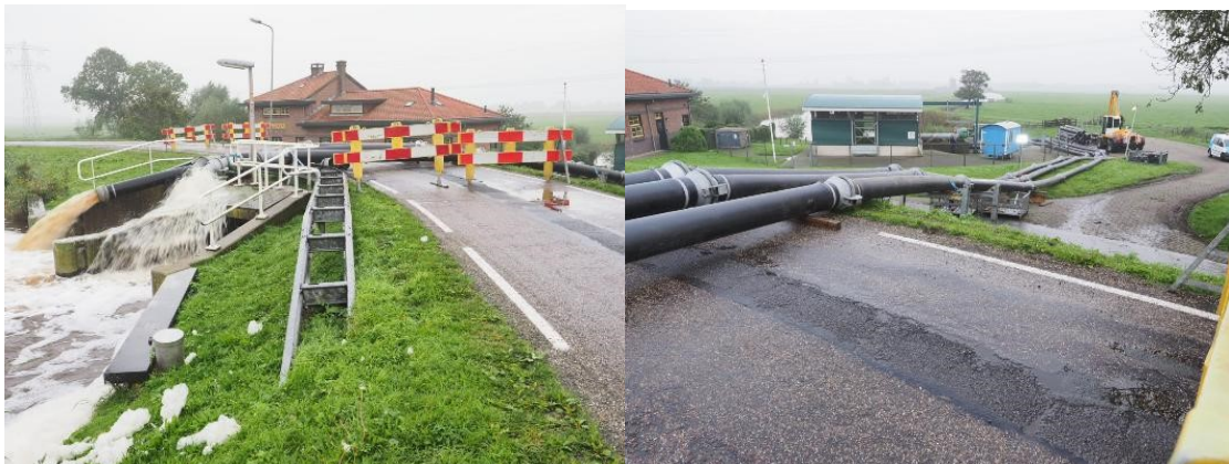
Figuur 3.5. Noodbemaling in de Schermer bij gemaal Willem-Alexander
