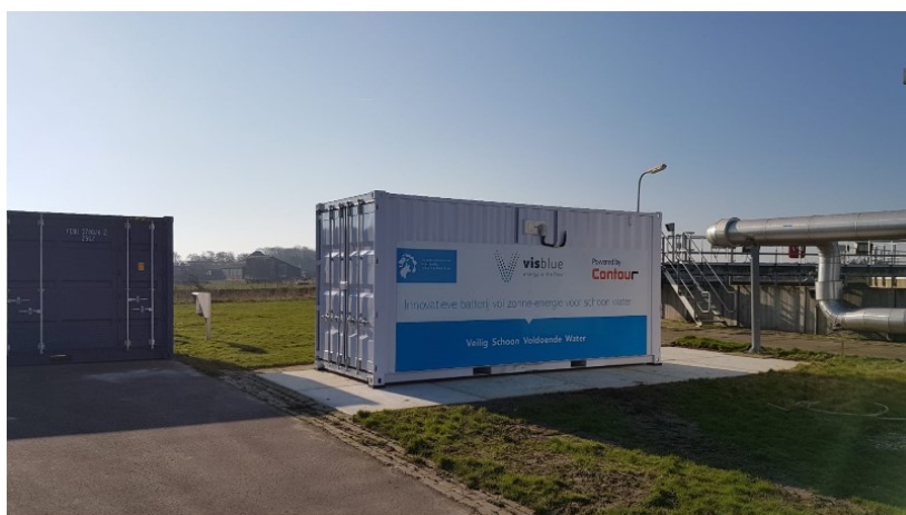
Figuur 6.5. De innovatieve batterij op RWZI Eversteekoog
